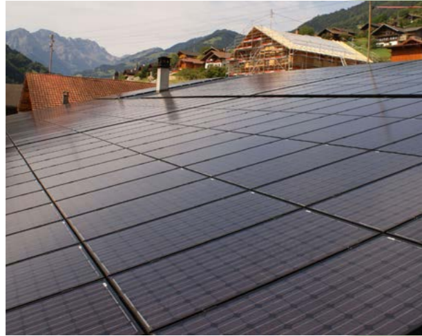
↓ Dachkonstruktion mit integrierten PVT-Modulen
